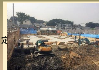
しょうじゅの里三保サテライト型施設 建設工事中
